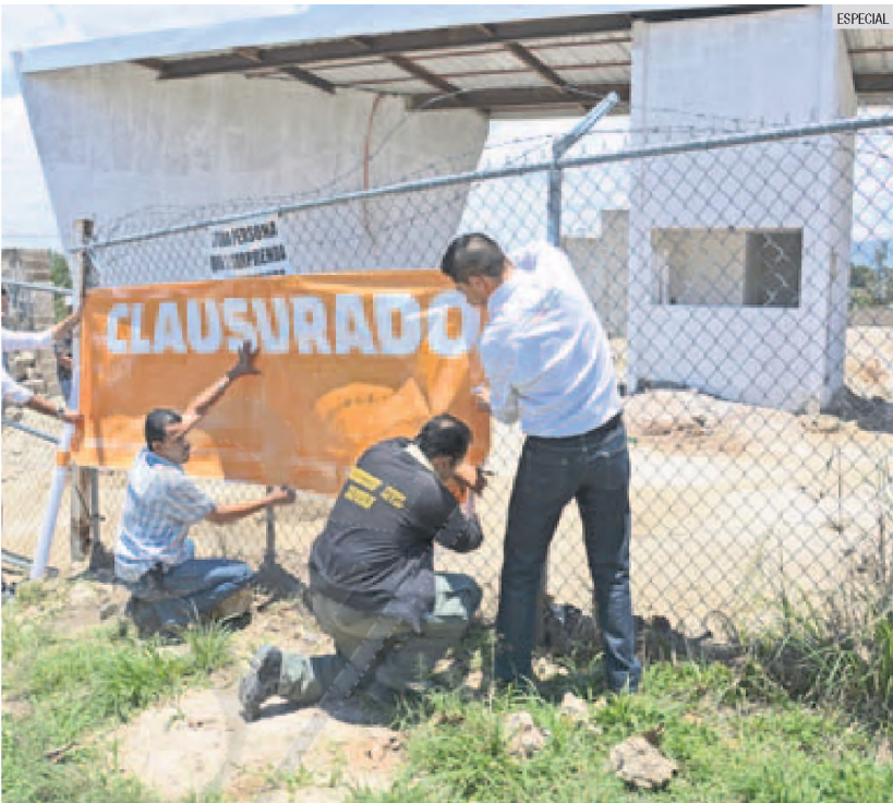
PELIGRO. Tras el colapso del muro perimetral del fraccionamiento Bosque Encantado, autoridades municipales cerraron la construcción por poner en riesgo a la población aledaña.
